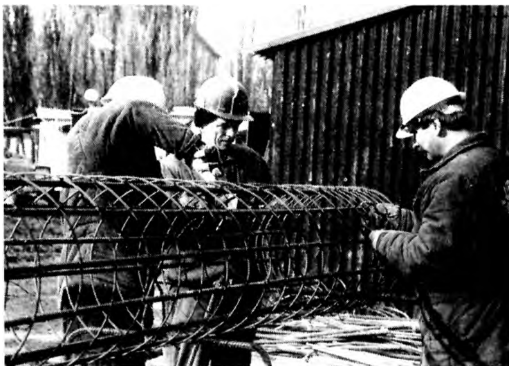
Cotygodniowa wizyta JM Rektora na placu budowy
