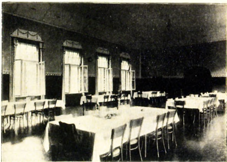
Sala jadalna Sanatorium w Rudcu.
