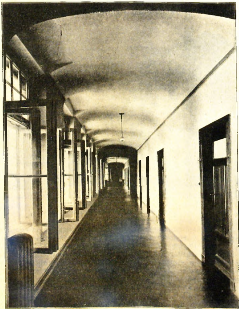
Korytarz w Sanatorium w Rudce.
